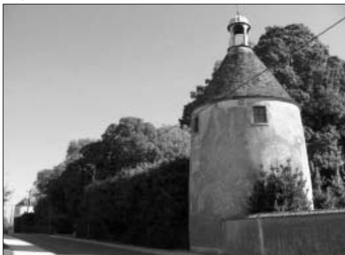
Zbytky opevnění v Boigny-sur-Bionne
